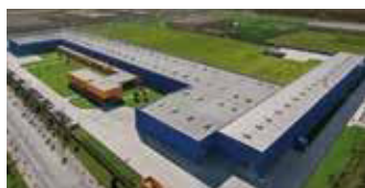
Hörmann Tianjin, Cina
